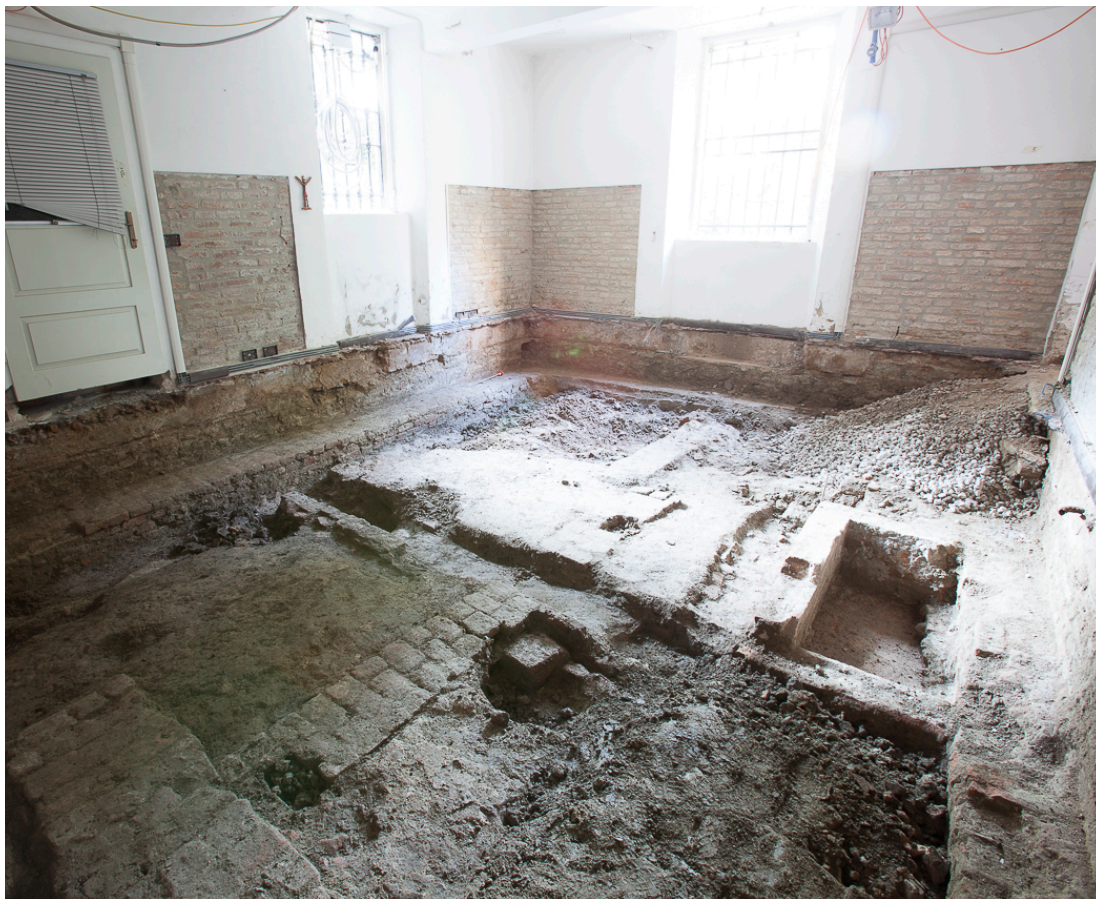
Condotti di ventilazione
