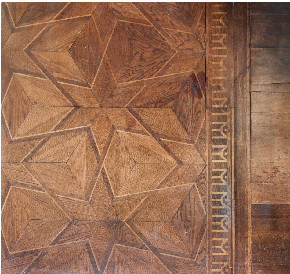
Pavimentazione in legno ad intarsi con forma romboidale
