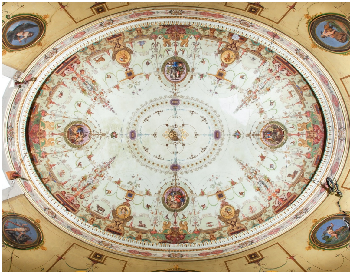
Foto interna – Soffitto al piano primo
